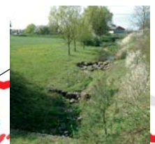
Hochwasserrückhaltebecken in Fridritt.
