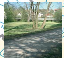
Hochwasserschutzdeich in Münderstadt.
