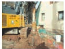
▲ Abb. 7: Einsatz des Bohrpfahlgerätes (Kelly Verfahren) zur Baugrubensicherung
