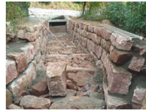
◀ Abb. 14: Anbindung des neuen Gewässerbettes an das neue Kastenprofil - Aufbau mit Sandsteinsohlschwellen, offener Gewässersohle und Ufersicherung aus Sandsteinquadern
