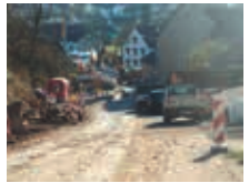
▲ Abb. 6: Straßenbaumaßnahme in Aura
