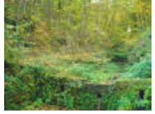
▲ Abb. 4: Eingewachsene Sperren bei niedriger Wasserführung
