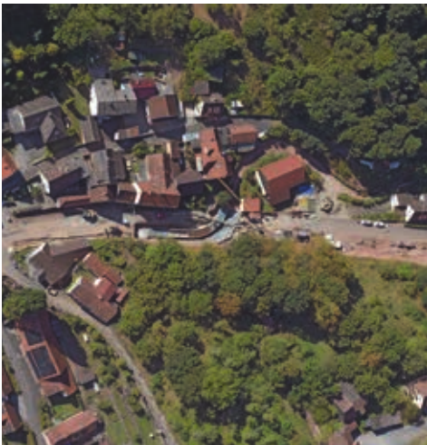
◀ Abb. 9: Luftbild der Baumaßnahme
