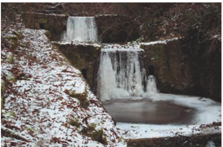
▲ Abb. 3: Eisbildung im Sperrenbereich
