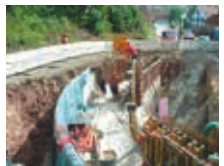
▲ Abb. 8: Bau der Straßenquerung des neuen Kastenprofils in den Sommerferien 2016
