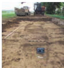
▲ Abb. 4: Bodenabtrag wurde von archäologischem Fachbüro begleitet.
