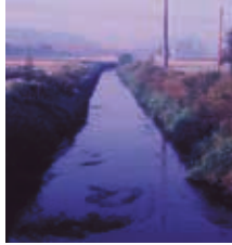
▲ Abb. 1: Kanalähnlicher Ausbau der Wern
