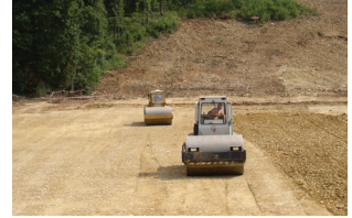
▲ Abb. 6: Verdichtungsarbeiten
