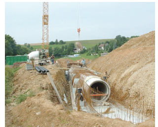
▲ Abb. 11: Verlegen des Grundablasses
