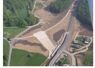
▲ Abb. 10: Der neue Damm von oben
