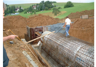
▲ Abb. 14: Armierung um den Grundablass
