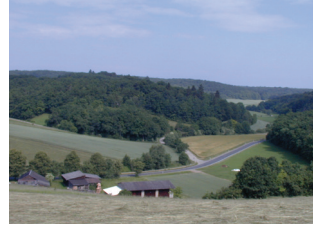
▲ Abb. 4: Blick auf den Damm
