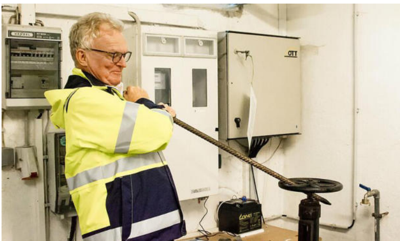
Foto: Anand Anders | Bevor der Schieber am großen Abflussrohr geöffnet wird, muss das kleine Abflussrohr erst dicht gemacht werden. Der Chef des Wasserwirtschaftsamtes, Leonhard Rosentritt, legt hier selbst Hand an.
