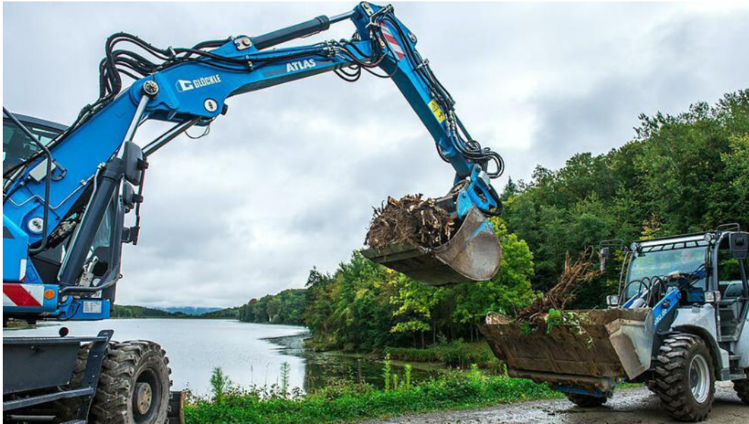
Foto: Anand Anders | Die Bauarbeiten am Vordamm haben begonnen. Das Wasser ist in diesem Bereich schon deutlich abgeflossen.
