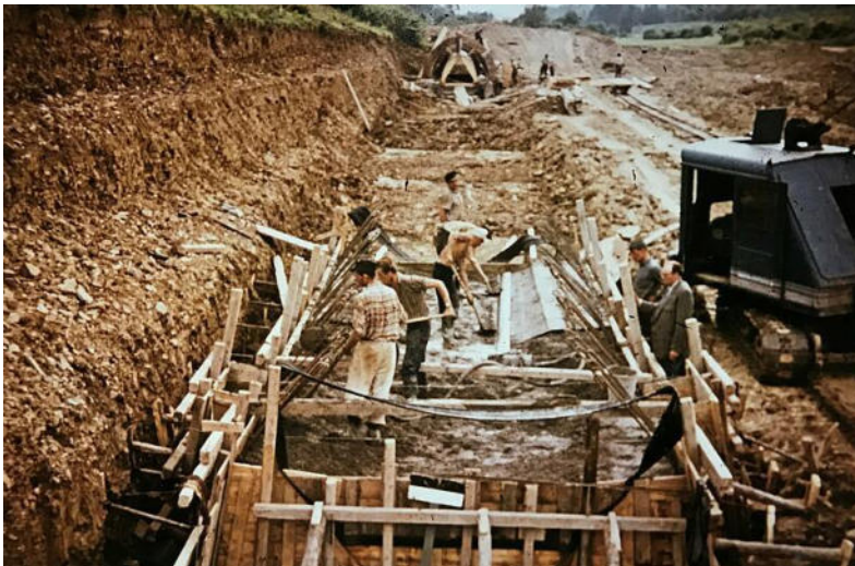
Foto: Wasserwirtschaftsamt Bad Kissingen | Der Dammbau war ein großes Ereignis in der Region.
