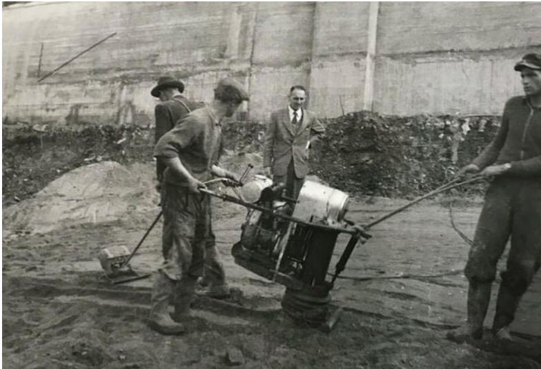
Foto: Wasserwirtschaftsamt Bad Kissingen | Das Verdichten des Damms erfolgte mit der Rüttelplatte. "Das hat mächtig gescheppert", erinnert sich Bernhard Weiler, der als Schulbub oft die Bauarbeiten verfolgte.
