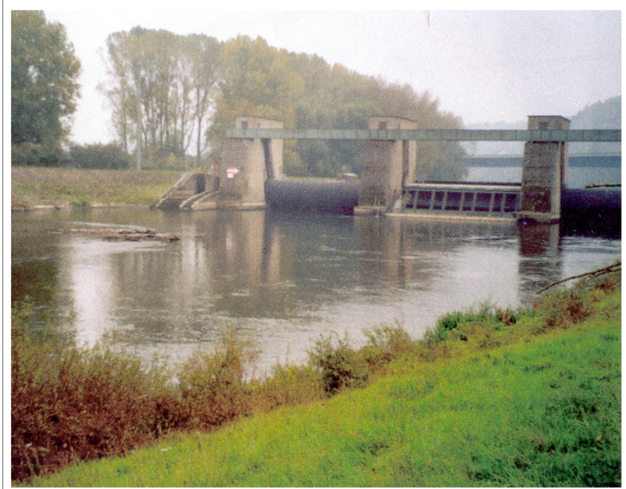
Foto: LRA Hallberg Ziel: Strukturvielfalt und Dynamik des Gewässerbettes stärken, Entwicklung der Tiefenvariabilität unterstützen Maßnahme: Buhnen oder Raubbäume einbringen
