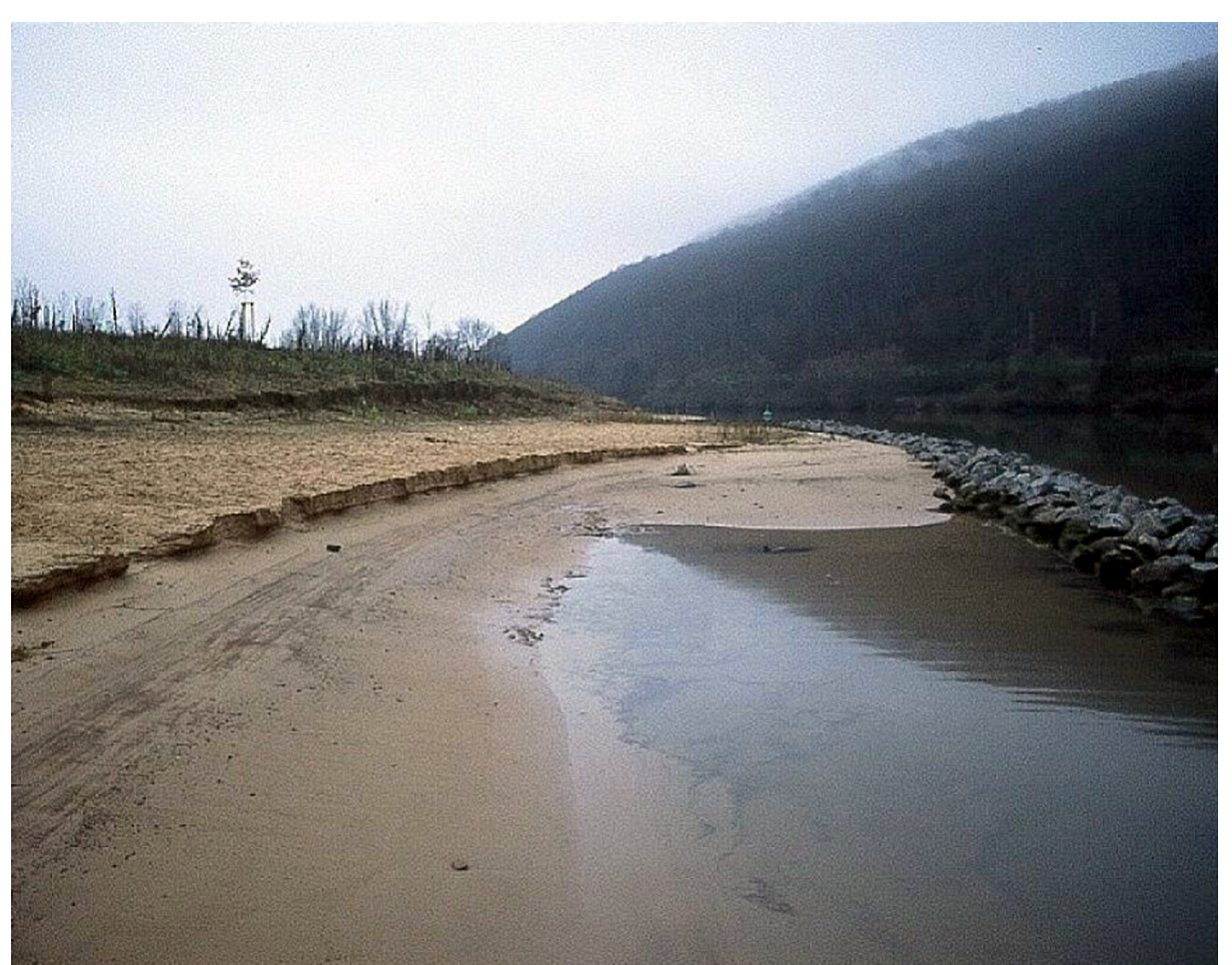
Foto: WWA Schweinfurt Ziel: Uferdynamik des Main verbessern, Verbau soweit möglich reduzieren; Maßnahme: als Ersatz für die Flachufer des unregulierten Main Ufer abflachen, Sukzession zulassen
