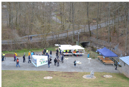
Ellertshäuser See: Feierlichkeiten am Auslaufbauwerk
