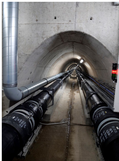
Ellertshäuser See: Stollen mit Ablaufleitungen DN400-PE
